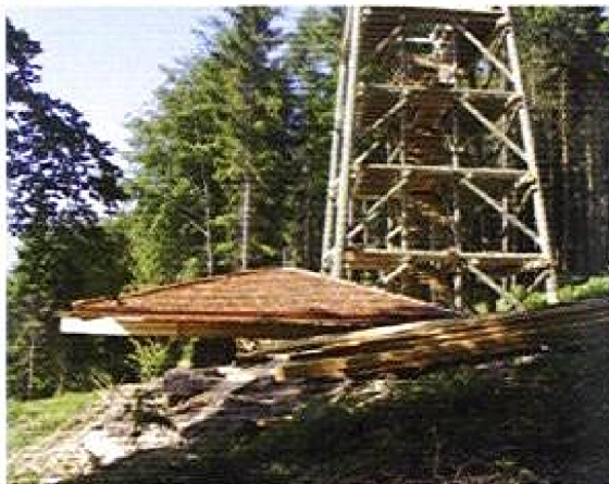
Manque plus qu'à poser le toit
